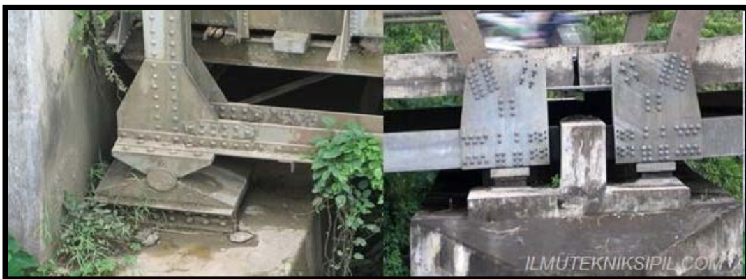
Gambar 29. Aplikasi tumpuan sendi pada struktur jembatan
