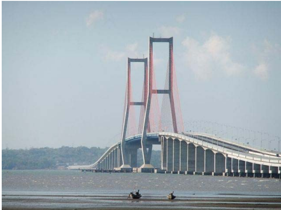
Gambar 11. Jembatan Suramadu (Surabaya Madura)
