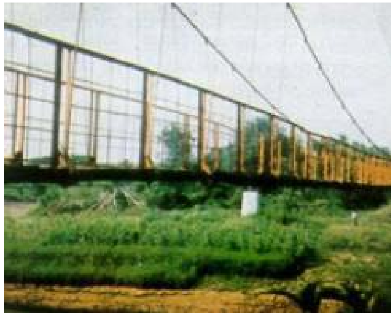
Gambar 12. Jembatan sederhana untuk lalu lintas ringan
