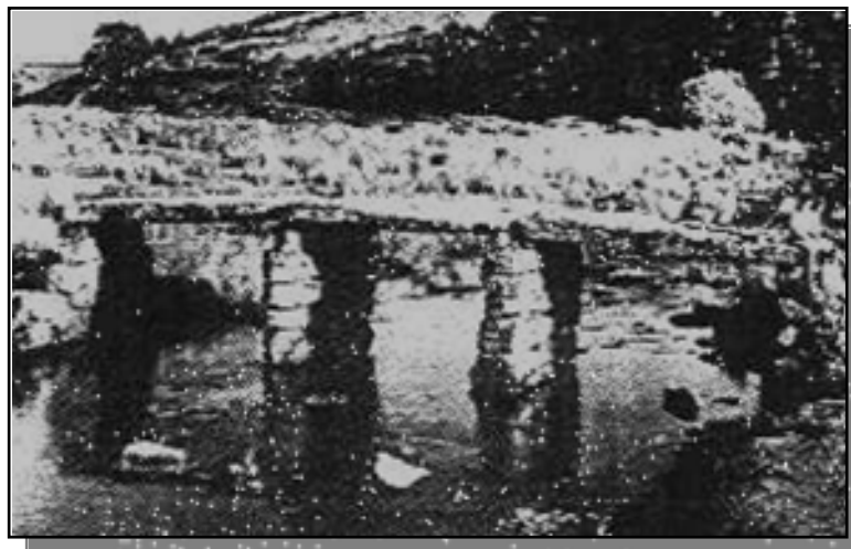
Gambar 2. Slab batu alam sebagai Jembatan
