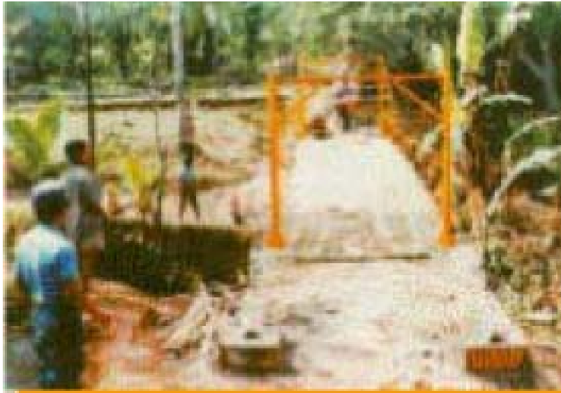
Gambar 15. Jembatan gantung pejalan kaki dengan kabel pengaku menggunakan komponen bambu, dipasang di Desa Padasenang, Sukabumi, Jawa Barat
