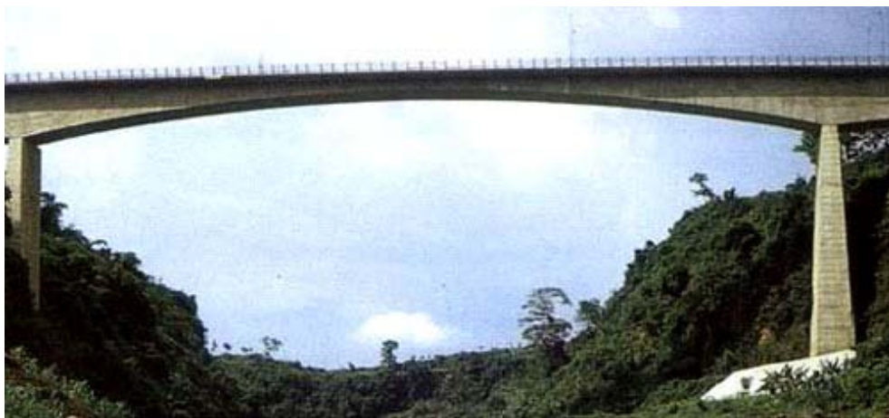
Gambar 8. Jawa Barat, Jembatan Box girder beton menerus Kelas-A, 1979. Bentang utama 132 meter san sisi simetris 45meter (total 222 meter).
