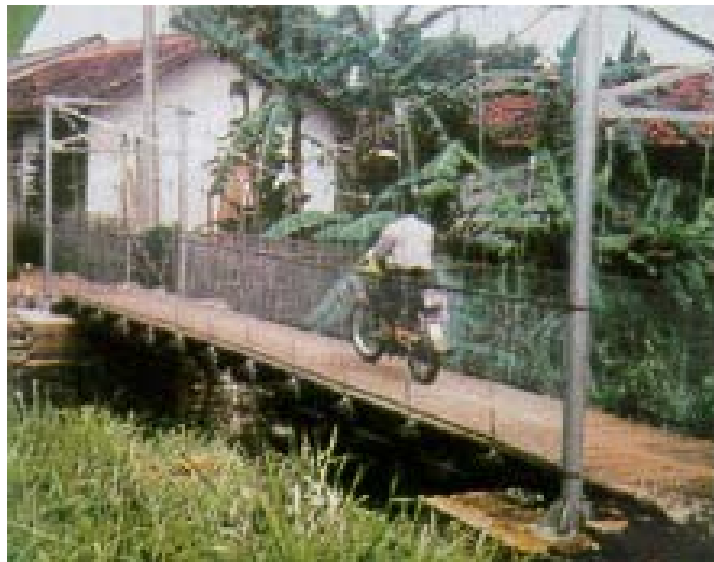
Gambar 13. Jembatan di Pedesaan
