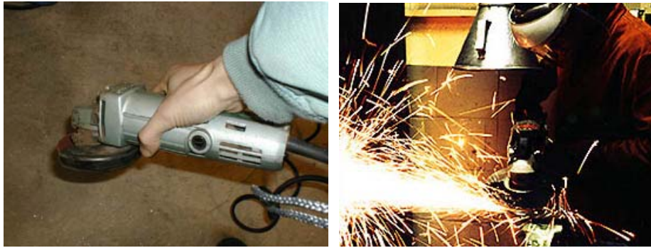
Gambar 11.20. Pekerjaan menggerinda dengan gerinda tangan
