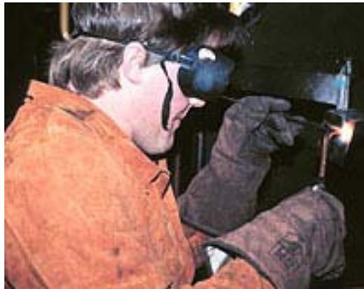
Gambar 7.1. Pekerjaan mengelas dengan *oxy-acetylene*
