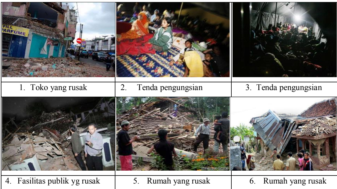
Foto 3.6.: Bangunan yang hancur akibat gempa bumi, Desa Jayapura Kecamatan Cigalontang Sumber: Dokumentasi, 2013.
