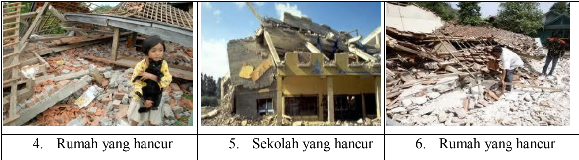
Foto 3.5.: Bangunan yang hancur akibat gempa bumi Desa Jayapura Kecamatan Cigalontang Sumber: Dokumentasi, 2013.
