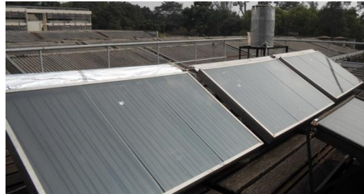
Gambar 7 Aplikasi pipa kalor pada solar kolektor.
