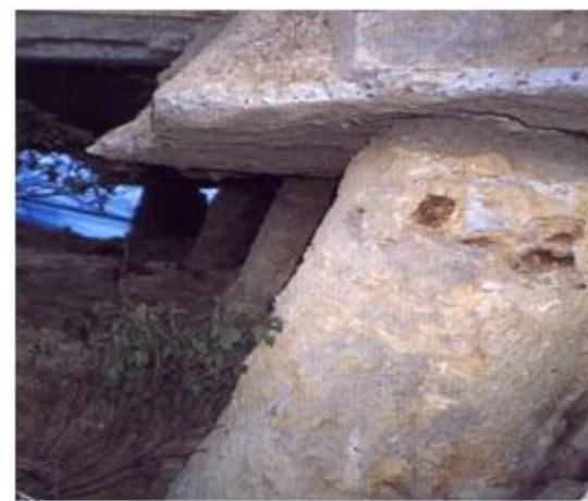
(d) Plastic hinge at the interface pile head and pile cap
